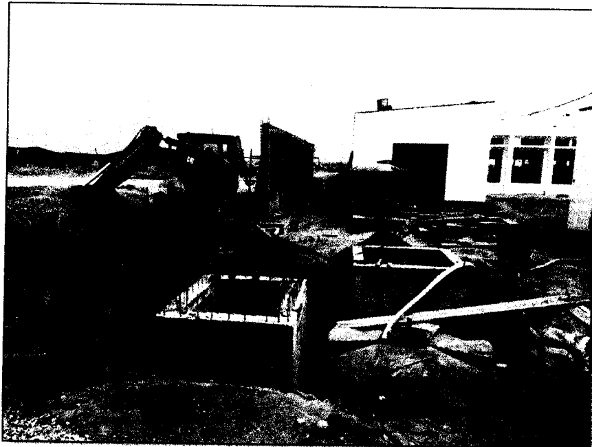
Acarreo del material de excavación
