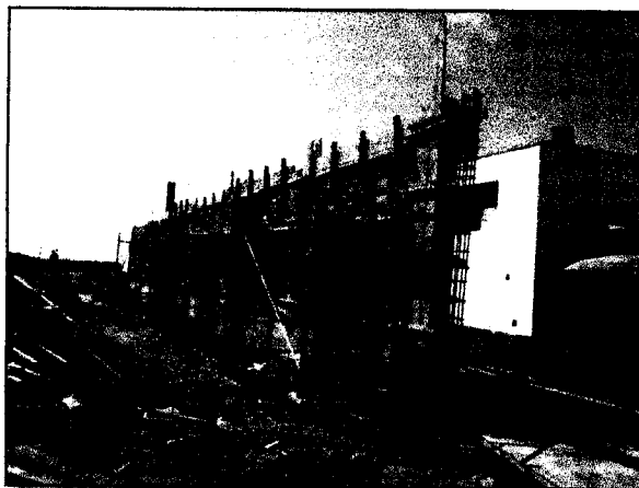
Armadura de refuerzo de las columnas del cerco perimétrico
