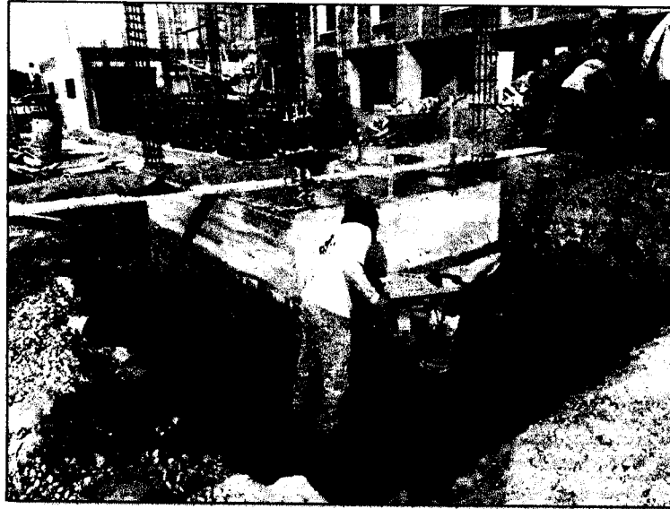
Relleno con material propio para los cimientos de la caseta de control de pesaje
