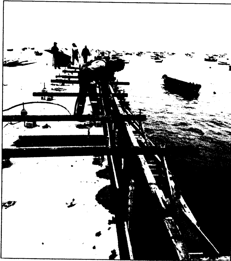
Vaceados in situ en los núcleos del cabezo del muelle
