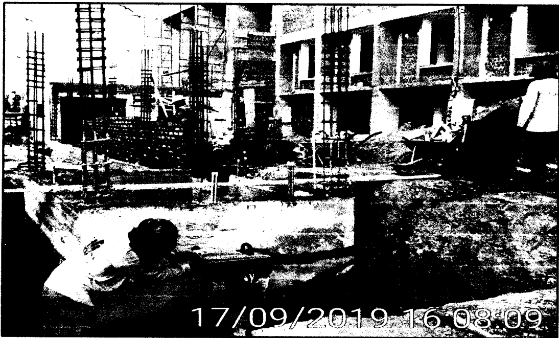
Imagen N° 5 Se observa en la imagen a los trabajadores haciendo trabajos de compactación en el perímetro de pesaje del desembarque con sus EPP's completos
