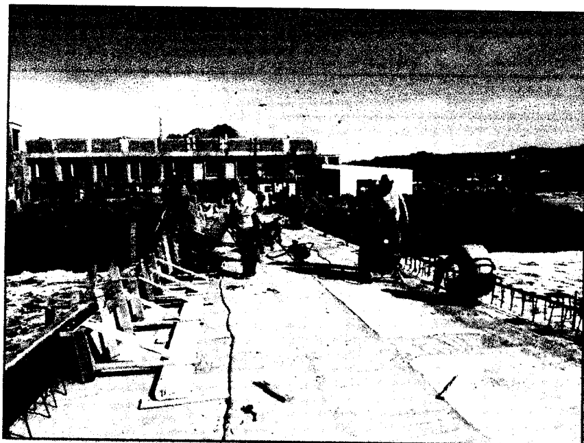
Vaceados in situ de los sardineles en el puente del muelle
