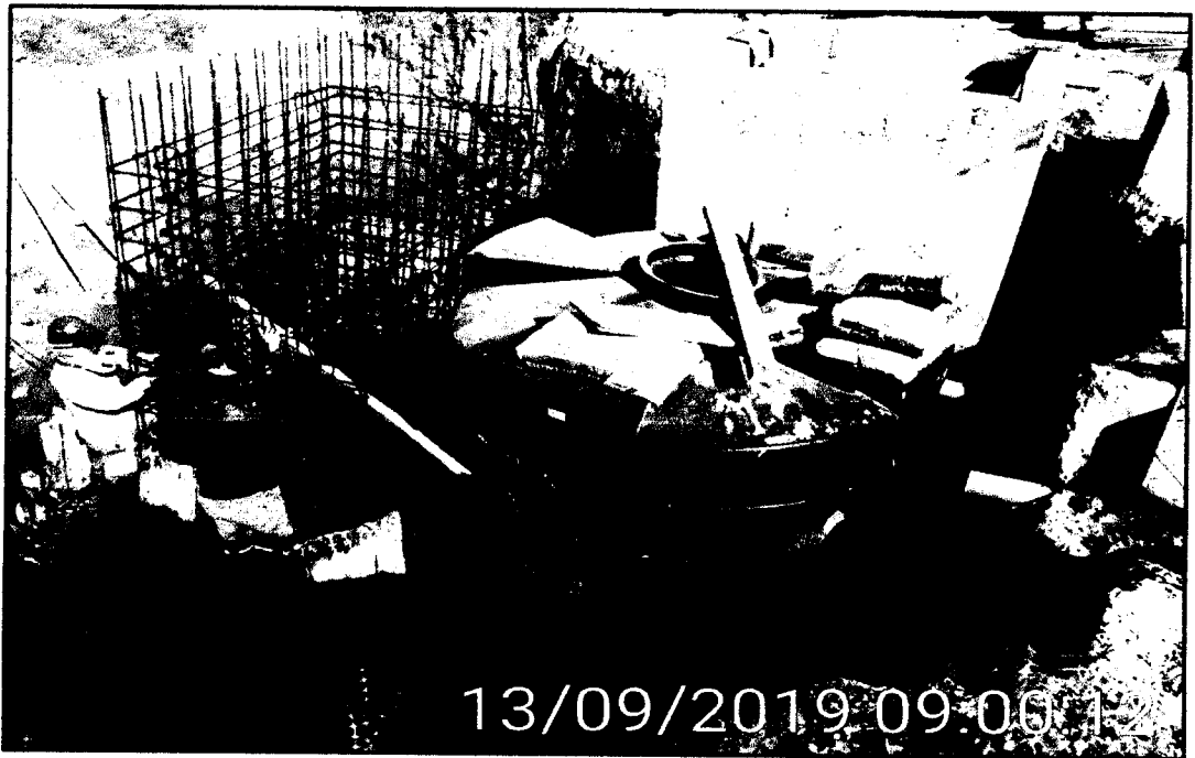
Imagen N° 7: La imagen muestra que los trabajadores han construido la cámara de lodos, se ha instalado el biodigestor (Tanque de Polietileno) y finalmente están haciendo armadura de acero en la cámara de bombeo con sus EPP's completos
