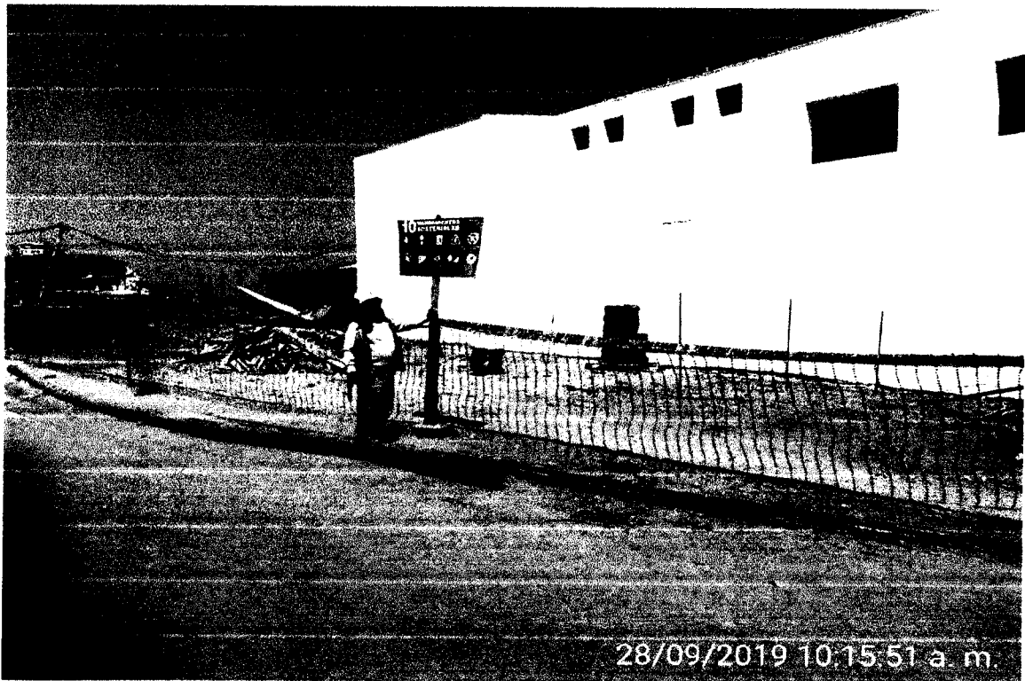
Imagen N°7: Se observa en la imagen que la obra esta señalizada con cintas y mallas de seguridad de acuerdo al DS. la G050 de Construcción Civil.
